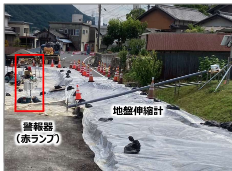
地盤伸縮計の設置状況
