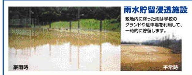
**雨水貯留浸透施設** 敷地内に降った雨は学校のグラウンドや駐車場を利用して、一時的に貯留します。
