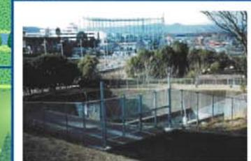
**防災調整池** 宅地造成等の市街地開発では河川への流出量が増大するため、防災調整池によって雨水を一時的に貯留し、流出を抑制します。
