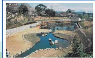
**ため池の治水利用** 地域の保水機能を高めるため、大雨時に、より多くの水を貯められるよう既存のため池施設を一部改良することで、洪水時に下流域の負担を軽減します。
