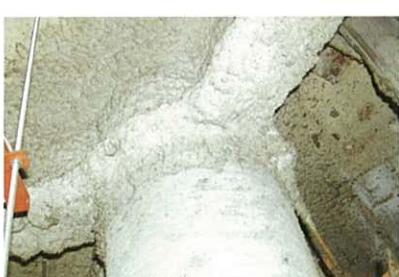
吹付けアスベストは、昭和50年に原則禁止となり、アスベスト含有吹付けロックウールは平成元年までに使用が中止されました。現在では、建築物にアスベストの飛散のおそれのある建築材料を使用することは全面的に禁止されています。平成元年以前に建てられた建築物に吹付け材が使用されている場合には、その吹付け材にアスベストが含まれているおそれがあるといわれています。
