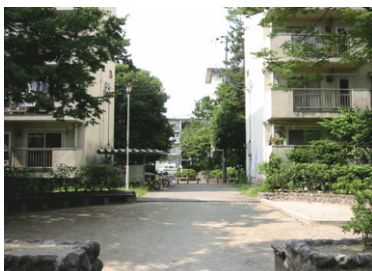
建替予定の中層住棟の団地 緑が豊か、エレベータが未設置
