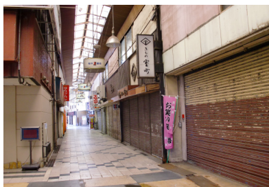
シャッター通りとなった商店街
