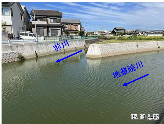
①前川合流部 (1.2km付近、改修済み)
