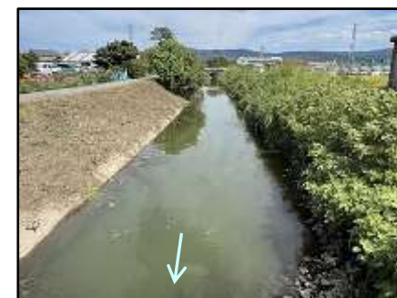
②無名橋より上流部 (未整備)
