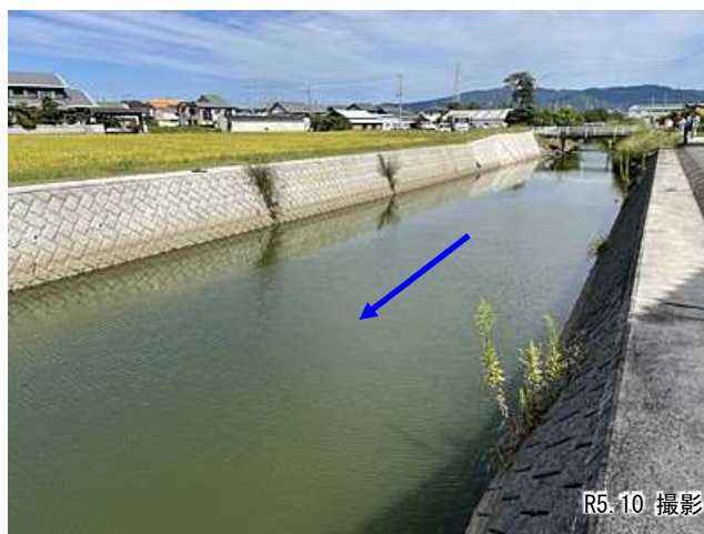
②前川合流部上流 (1.3km付近、改修済み)
