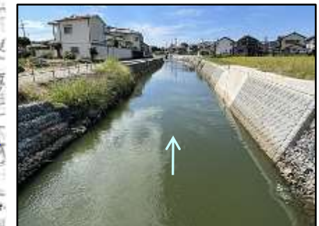
①無名橋より下流部 (右岸整備済み)
