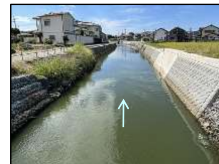
①無名橋より下流部 (右岸整備済み)
