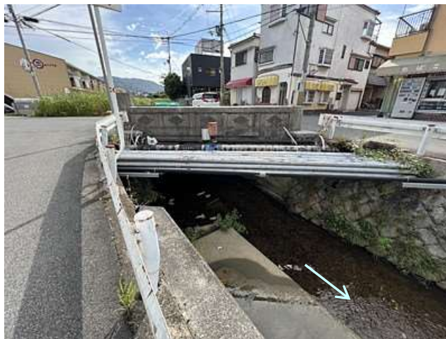
①恵比寿橋 (0.5km付近、未改修)
