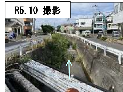
①恵比寿橋より下流部 (未整備区間)
