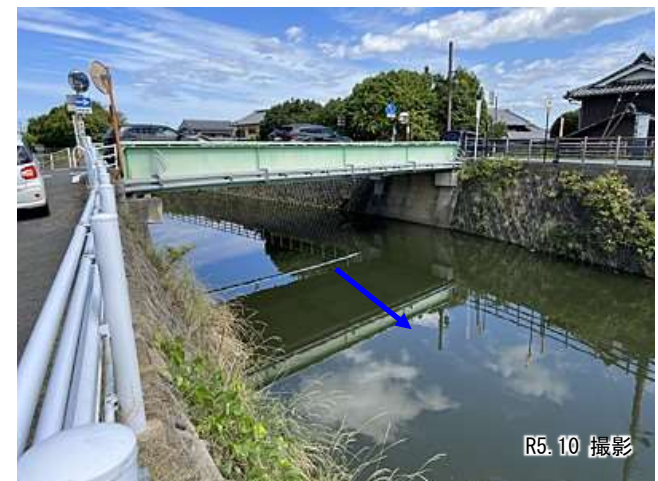
③右京橋 (2.0km付近、未改修)
