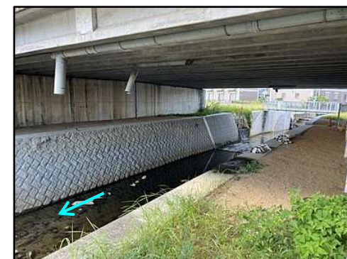
②一号堰より下流(整備済み)
