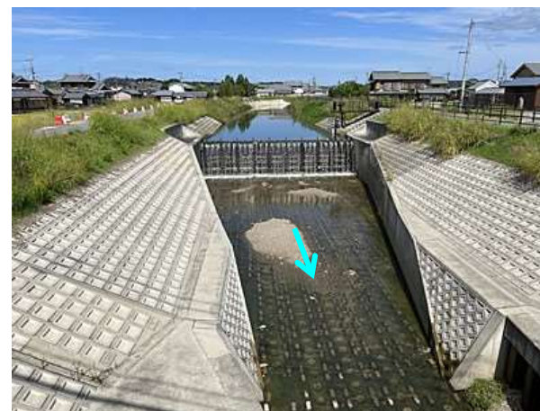
②下堂共同井堰本体付近(整備済み)
