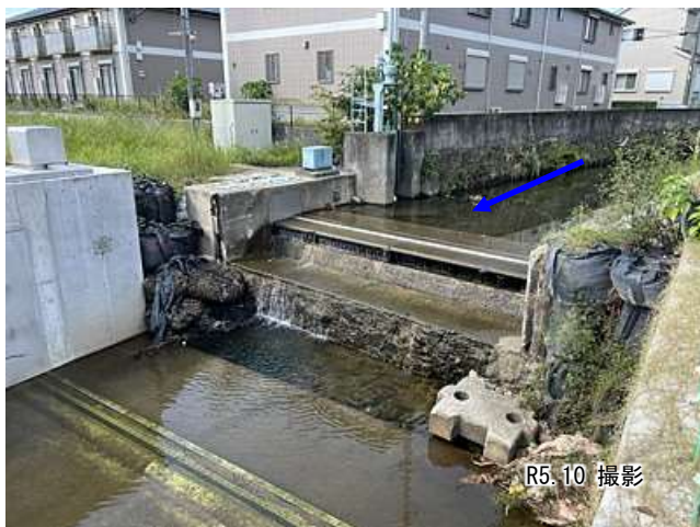
①一号堰 (7.6km付近、堰改築中)
