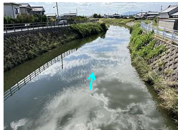
①右京橋より下流部(未整備)
