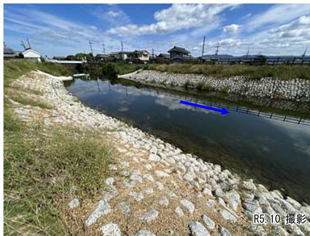
②右京橋下流 (1.9km付近、改修済み)
