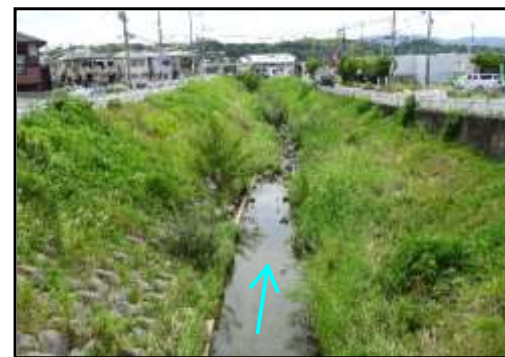
①中山橋より下流部(整備済み)
