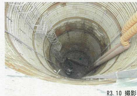
③国道165号(バイパス水路流入立坑)
