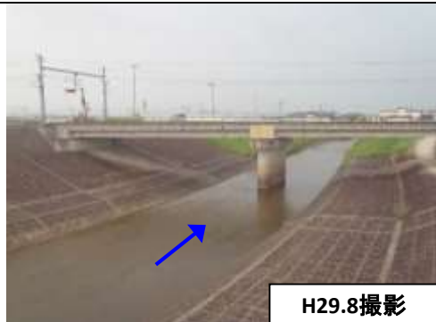
①安堵工区（改修済み区間）
