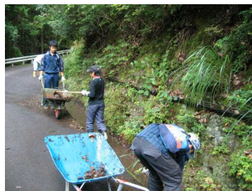
側溝から泥をかき出す
