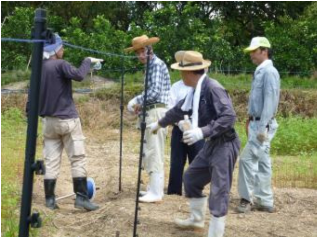
景行天皇陵付近のそば畑を守る太陽光電柵の設置作業
