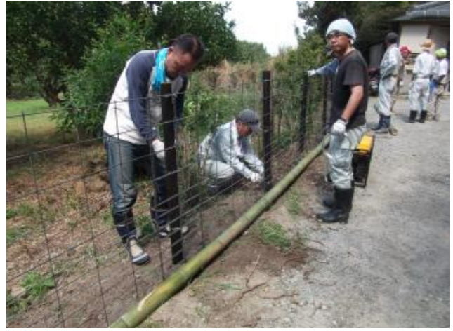
松原神社付近の鳥獣柵(竹、間伐材利用)の設置作業
