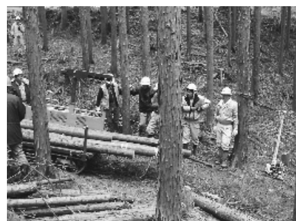
平成19年 搬出作業
