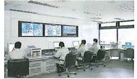
奈良県防災行政無線統制室
