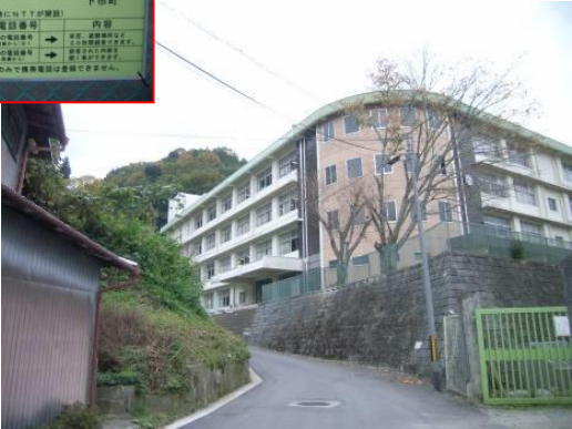
下市中学校 (地域防災計画に位置付けられている避難所)
