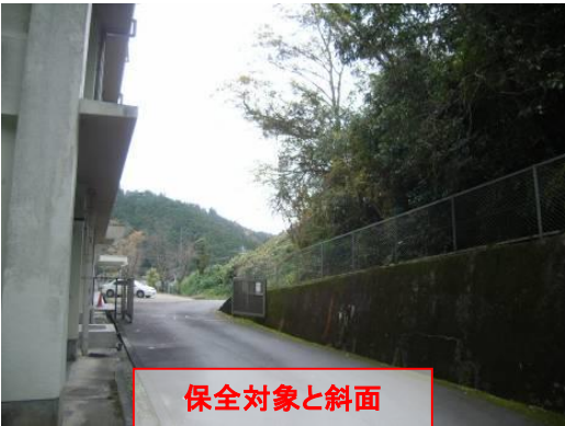
保全対象と斜面
