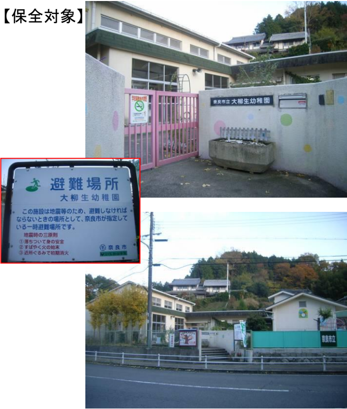
大柳生幼稚園 (地域防災計画に位置付けられている避難所)
