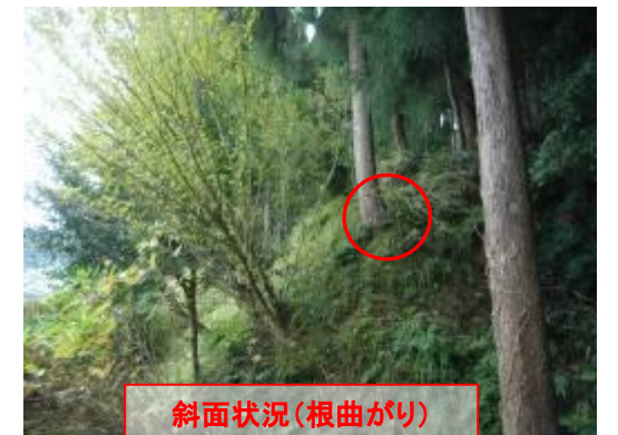
保全対象と斜面
