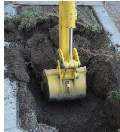
写真-6 小型バックホーで楽に掘削
