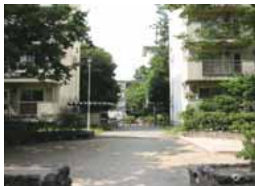
建替予定の中層住棟の団地 緑が豊か、エレベータが未設置
