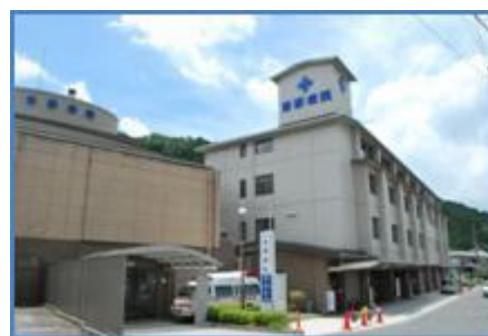
地域医療センター （国保吉野病院を改修）
