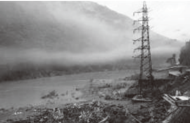
写真 18 平成23年9月4日 増水により流された長殿発電所
