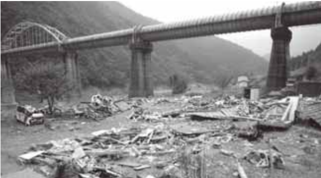
写真 20 平成23年9月5日 対岸での崩壊によって流れが変わった河川に押し流された村営住宅
