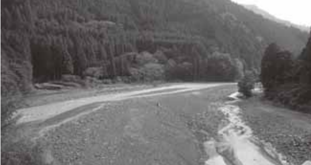
写真 22 平成23年9月28日 神納川被災状況
