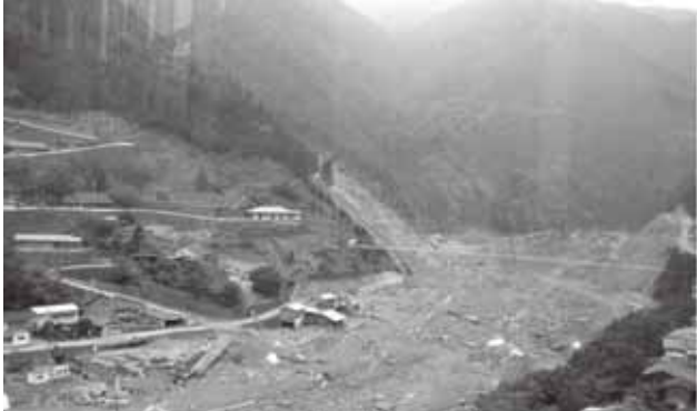
写真 16 平成23年10月11日 被災後の状況（五條市大塔町宇井地区）
