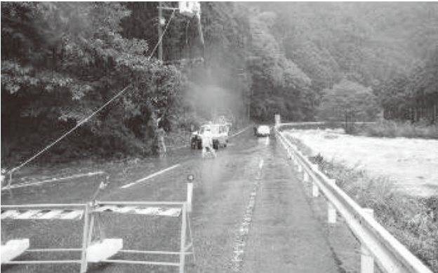
写真 36 平成 23 年 9 月 3 日 高圧配電線復旧 (東吉野村)
