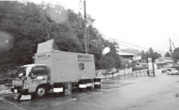
写真 34 平成 23 年 9 月 5 日 高圧発電機車による応急送電 (五條市大塔町)
