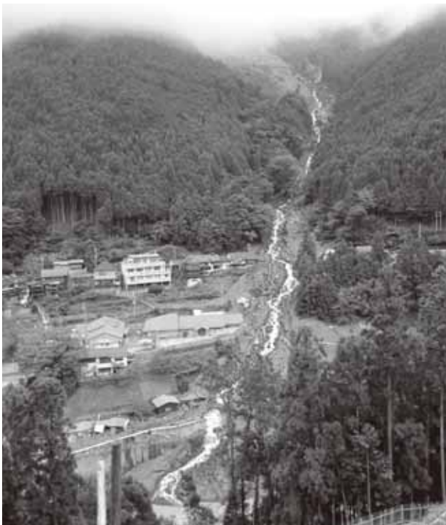
写真 42 平成 23 年 9 月 5 日 熊野川対岸より崩落状況
