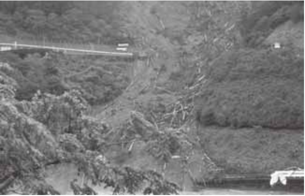
写真 2 崩土（川上村迫地区）
