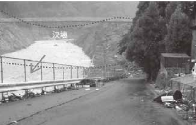
写真29 河道閉塞・決壊の状況 (五條市大塔町宇井地区)
