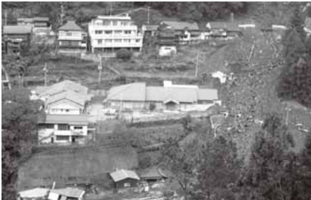
写真 45 平成 23 年 10 月 25 日 保育所(左側)とデイサービスセンター(右側)
