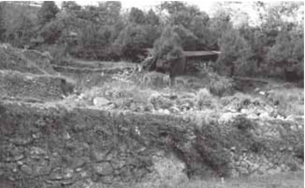
写真 49 平成 23 年 10 月 31 日 農地の被災状況（十津川村玉置川地区）
