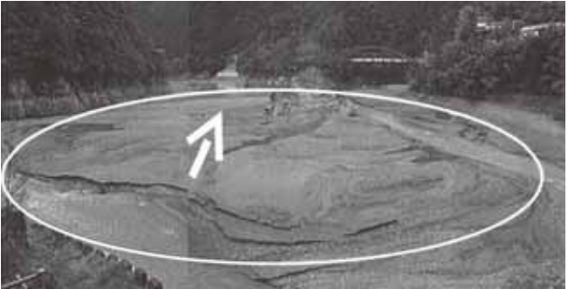
写真 27 二津野ダム堆砂状況
