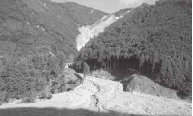
写真 52 平成 23 年 9 月 12 日 林地の崩壊と土石流被害の状況（十津川村野尻地区）
