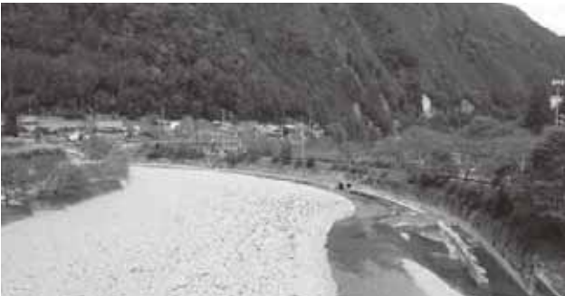
写真 21 平成23年10月3日 北山川被災状況
