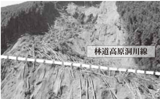
写真 55 平成 23 年 10 月 28 日 林道高原洞川線の崩壊（川上村高原地区）
