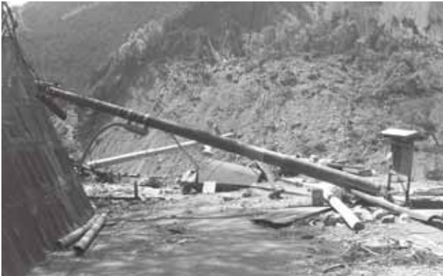
写真 33 平成 23 年 9 月 8 日 電柱倒壊 (五條市大塔町)
