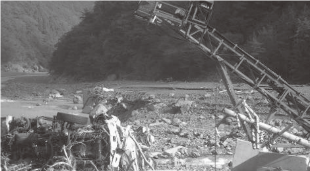
写真 23 平成23年9月29日 川原樋川被災状況
