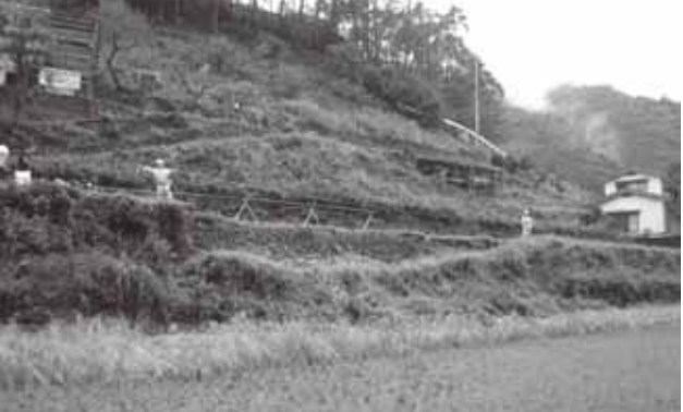
写真 48 平成 23 年 9 月 26 日 農地の被災状況（十津川村出谷地区）
