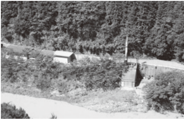
写真 41 水没した施設
