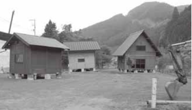
写真 72 天川村のオートキャンプ場被害
