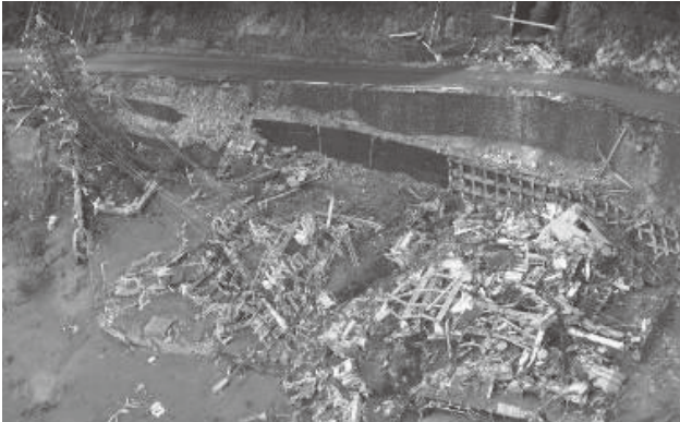
写真 32 平成 23 年 9 月 5 日 長殿発電所 (十津川村)
