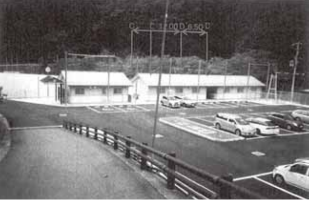
写真 63 平成 18 年 9 月 被災前の体育倉庫
