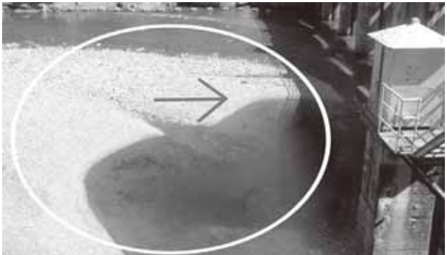
写真 26 九尾ダム堆砂状況
