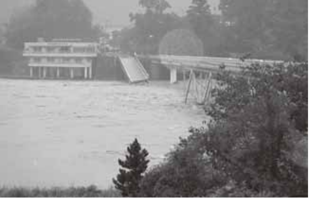
写真 1 折立橋落橋（十津川村折立地区）
