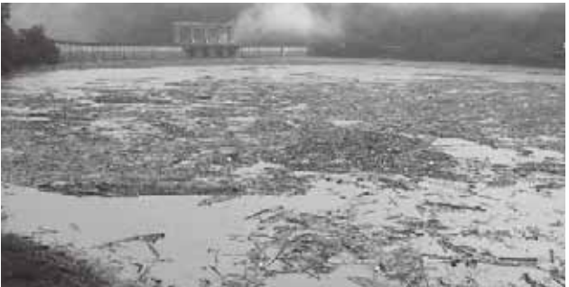
写真 28 平成23年9月26日 風屋ダム被災時の状況
