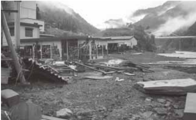
写真 74 十津川村の事業所被害
