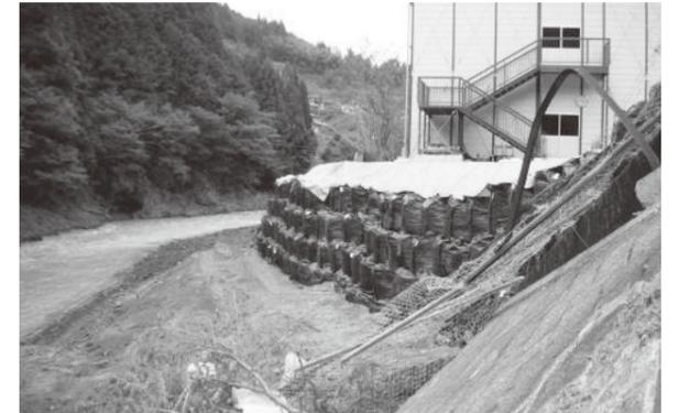
写真71 平成23年9月18日 西川中学校(十津川村)の護岸の応急工事後
