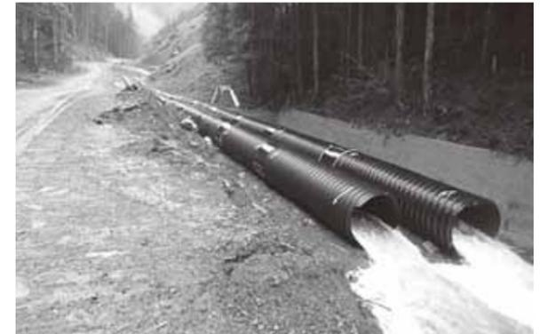
写真73 平成24年2月7日 坪内谷地区の応急仮設水路（天川村）
