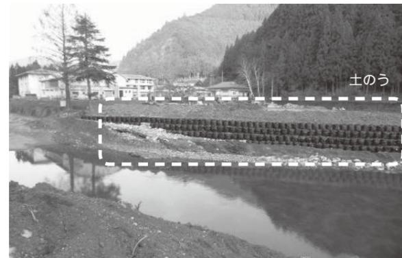
写真70 平成23年12月14日 護岸の応急復旧工事後（天川村南日裏地区）
