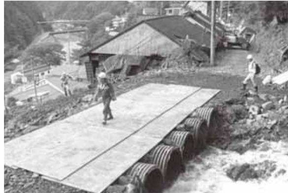
写真 54 被災箇所での仮道 (五條市大塔町辻堂地区)
