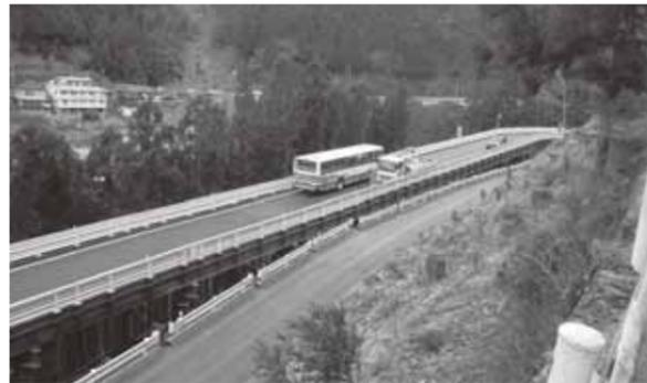
写真 57 工事用栈橋の活用 (五條市大塔町辻堂地区)
